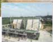
永康抽水站抽水機組更新工程
