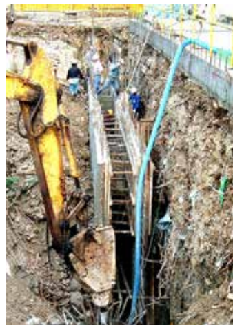
9m 深導溝施工
