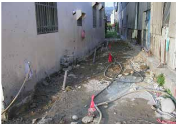
低壓灌漿建物扶正規劃及施工
