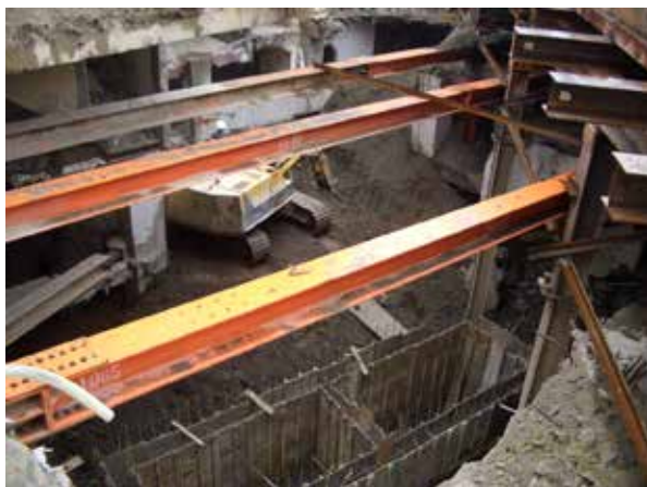
既有大樓地下三層基礎破碎及 12m 深導溝施工
