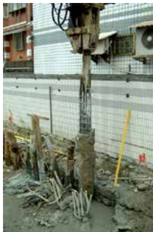
既有排樁拔除
