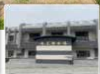
麻豆工業區市地重劃抽水站新建工程
