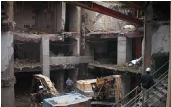
既有大樓地下三層基礎破碎及 12m 深導溝施工
